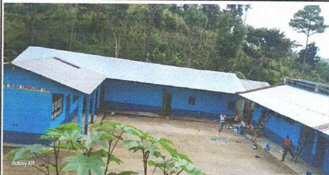
Foto 2: Colocación y finalización del cambio de techo en las aulas módulo 2.
