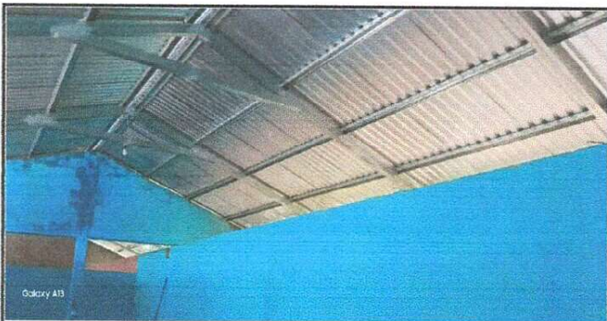
Foto 3: Finalización e instalación de láminas y costaneras módulo 2.
