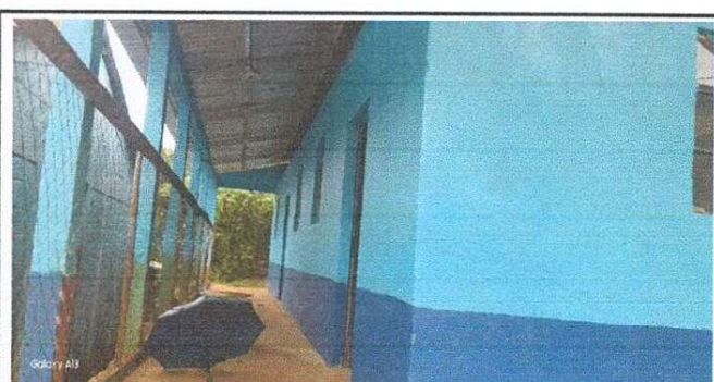
Foto 4: Finalización de pintado de las aulas parte exterior, módulo 1.
