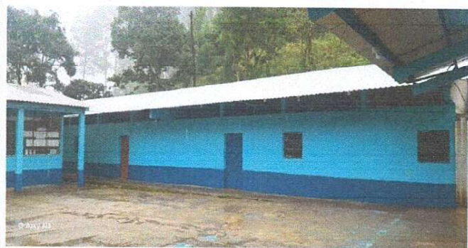
Foto 1: Terminación de pintado de las aulas módulo 2.
